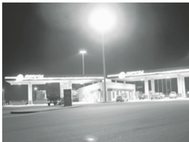
Estació de servei
